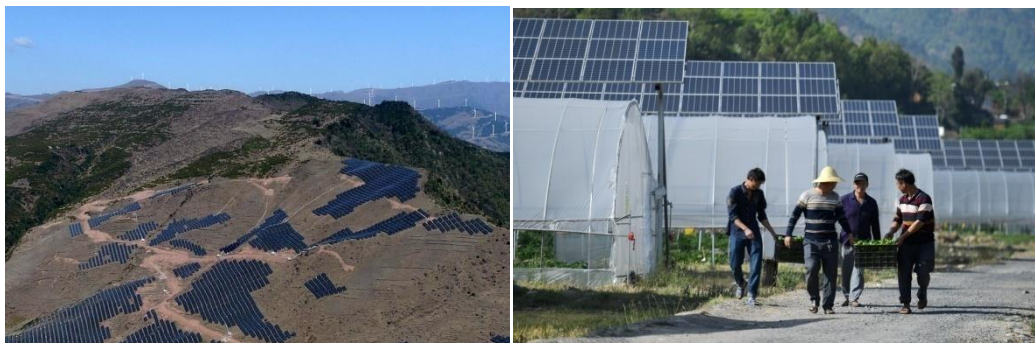
图 1.四川省凉山州光伏发电扶贫
